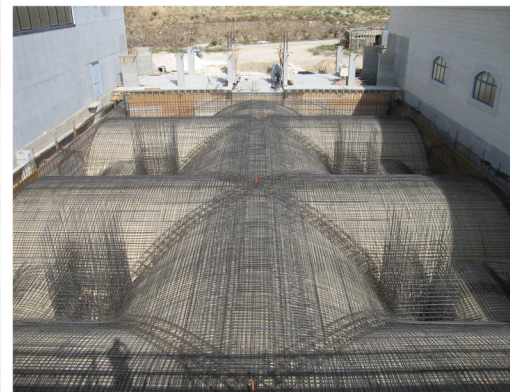
3. COSTRUZIONE DELLE VOLTE IN CEMENTO ARMATO
