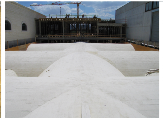
2. COSTRUZIONE DELLE VOLTE IN TUFO
