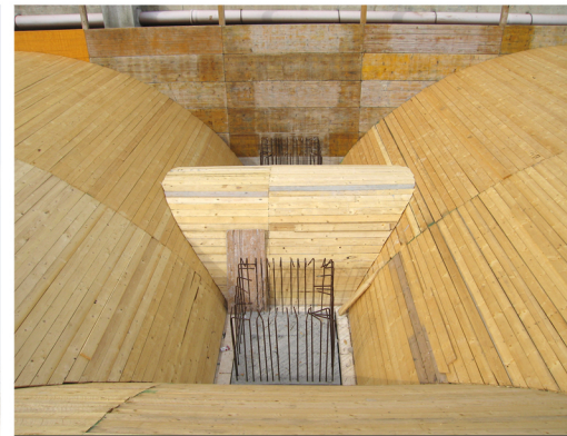
1. COSTRUZIONE DELLE CENTINE IN LEGNO
